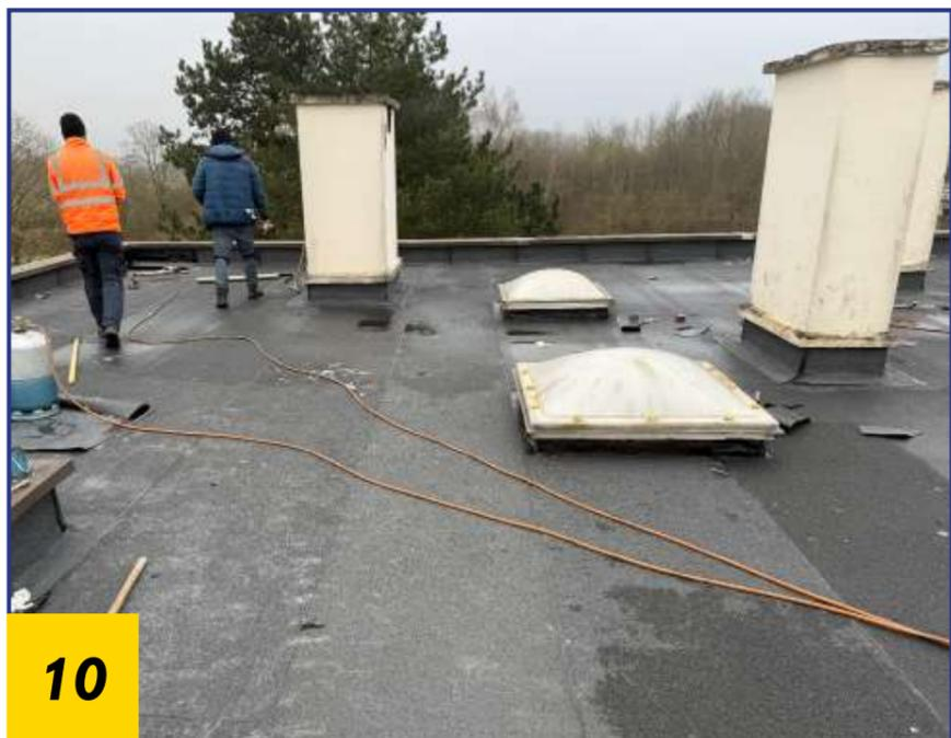
Des fissures, dues à l'usure du temps sont apparues et se sont rapidement aggravées, nécessitant une intervention rapide pour empêcher la pluie de pénétrer à l'intérieur de l'édifice.
